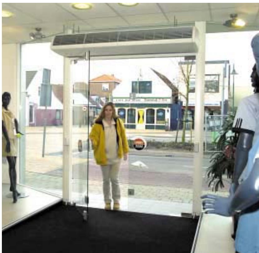
A Snuffel ruhaüzletben a légfüggöny megvédi a kellemes bolti klímát mialatt az ajtó nyitva van.
