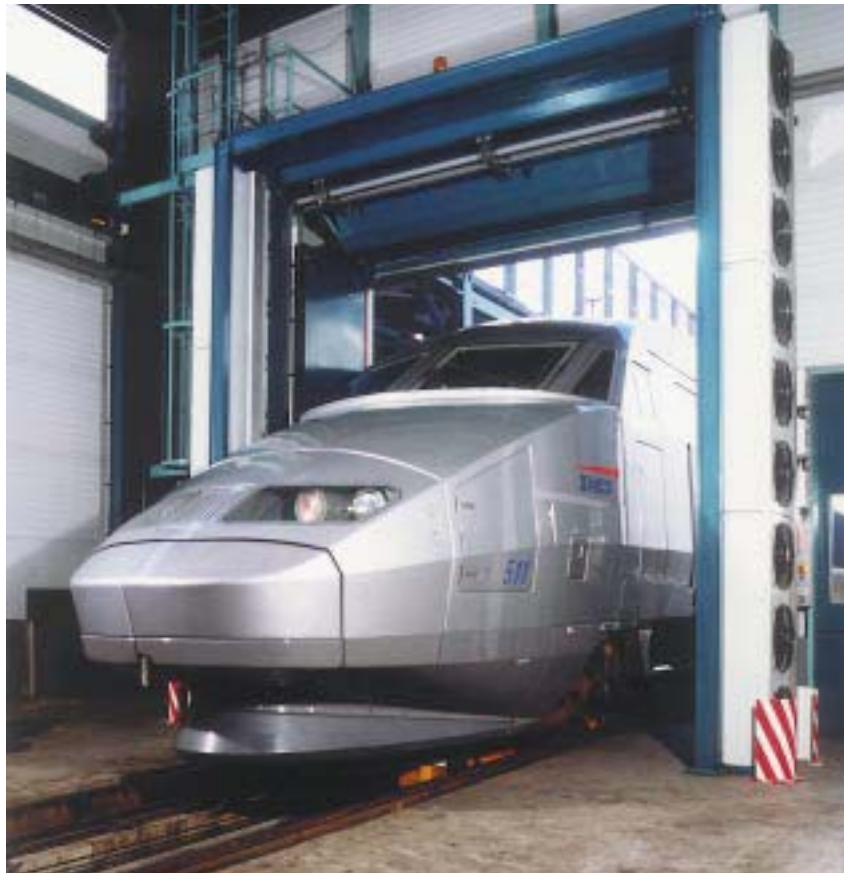
A Biddle ipari légfüggöny felmelegíti a beáramló hideg levegőt
